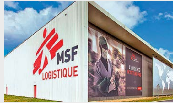
Die Lagerhallen bei Bordeaux bieten 12'800 m 2 Lagerfläche. Notfallkits und Medikamente werden hier zwischengelagert, bevor sie in die Einsatzgebiete transportiert werden. ©Kristo Photographie
