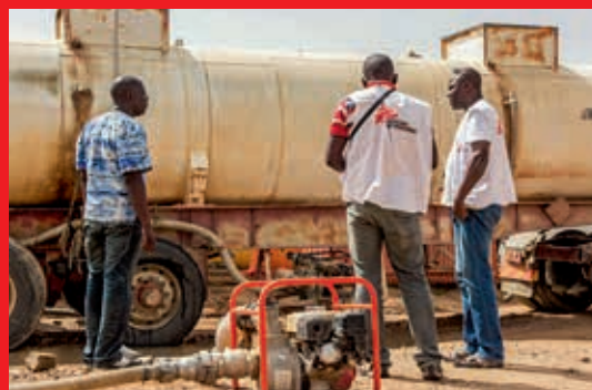
Les cinq stations de pompage installées à proximité du camp permettent d'extraire 800 m3 d'eau par jour. ©Tristan Pfund/MSF
