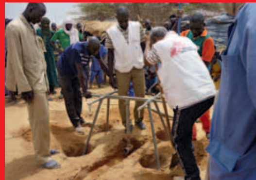
Bau einer Installation zur Wasserversorgung. © Jorge Mazuze/MSF
