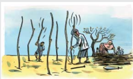
Zuerst gräbt man mit Hilfe einer Eisenstange Löcher in den Boden. Dann steckt man dünne Zweige in die Löcher.
