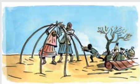
Die Zweige werden zur Mitte hin zu einem Bogen zusammengeführt und befestigt ...
